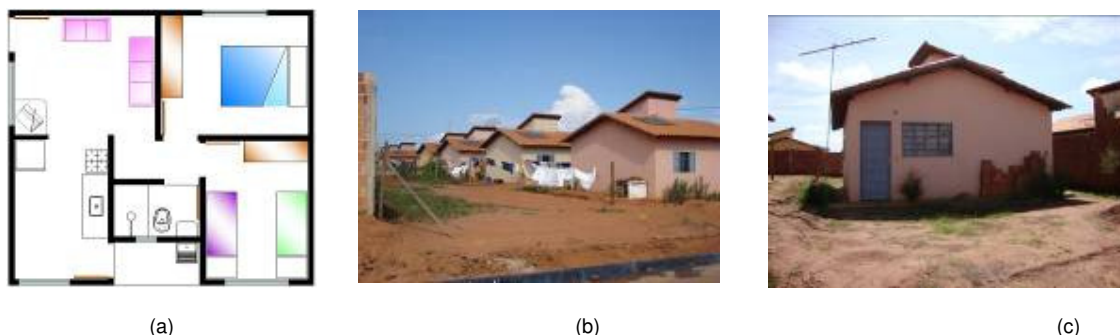
FIGURA 2 – O Conjunto Habitacional Campo Alegre – (a) Planta das residências do Conjunto Campo Alegre, (b) Imagem do conjunto, onde é possível observar que não há diferenciação formal entre as casas, além de não existir privacidade entre os moradores, (c) Imagem de uma das unidades habitacionais do conjunto, onde nota-se a falta de revestimento externo e muros entre os vizinhos. Fonte: VILLA, 2010.
