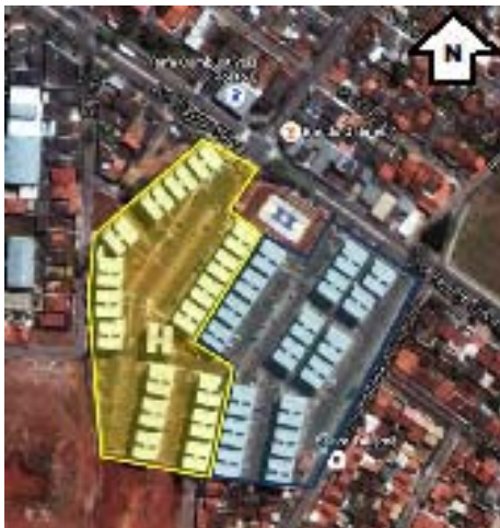
Figura 5 – Vista superior do Res. Tocantins 1 (azul) e Res. Tocantins II (amarelo).
