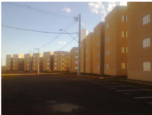
Fotografia 2 – Vista interna do Residencial Tocantins II.
